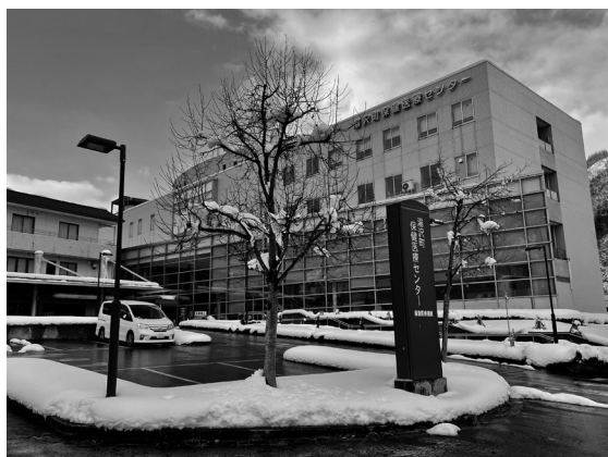
湯沢町保健医療センター 病院正面（3月）
